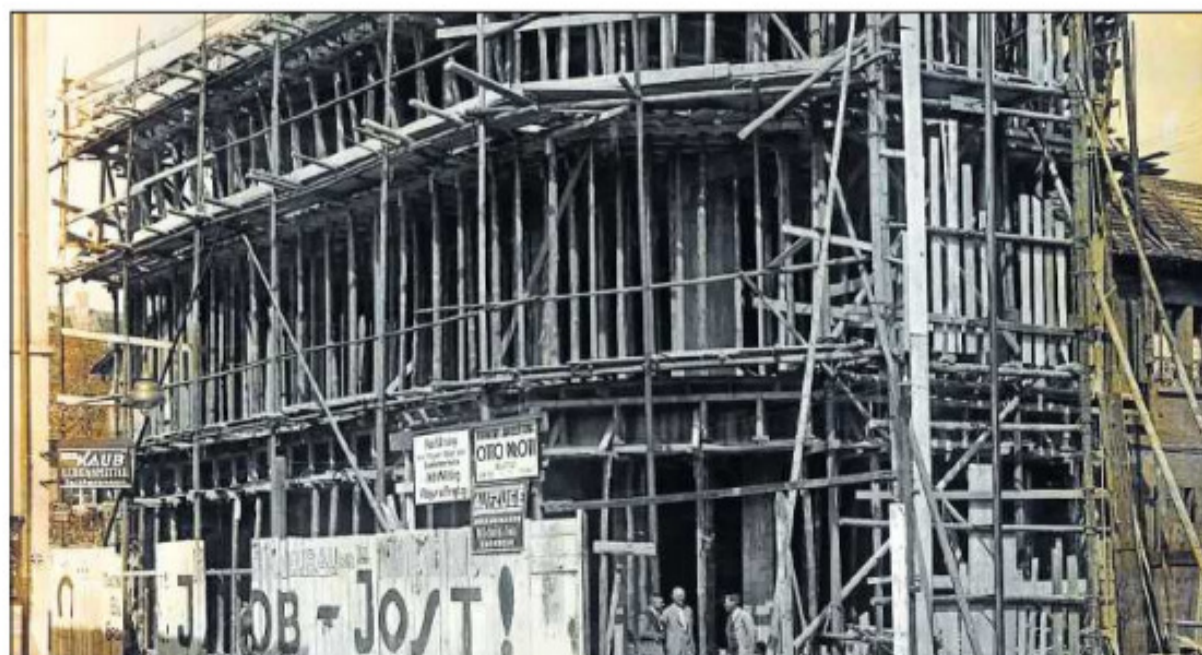
Eindrucksvoll ist das Eisenskelett, das beim Bau des Kaufhauses Jost für die Armierung der Betonwände errichtet wurde. Am 4. August 1932 ist die Eröffnung gefeiert worden.
